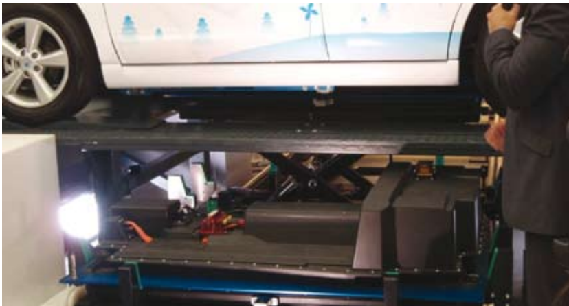
Batteriskiftestation hvor batteriet udskiftes fra bunden af bilen (Foto: Esben Larsen)
